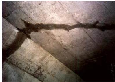
地下ピット内漏水状況
