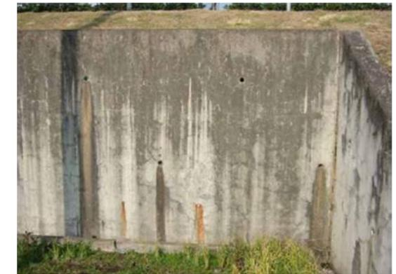
アルカリ骨材反応の事例(亀甲状ひび割れ)<sup>きっこう</sup>
