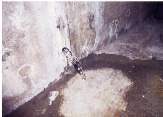
地下機械室 漏水箇所(施工前)
