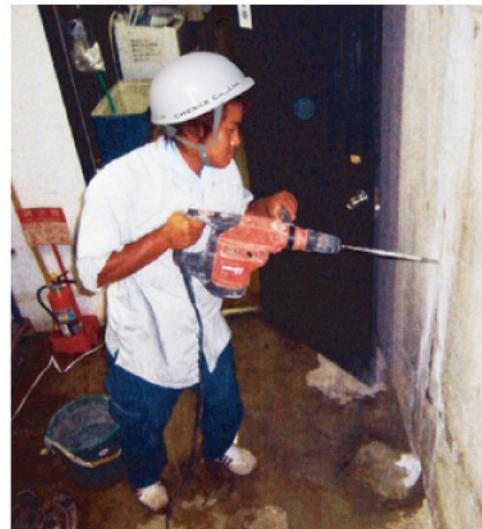
确认裂缝和白华漏出地方用锤钻头做穿孔。
