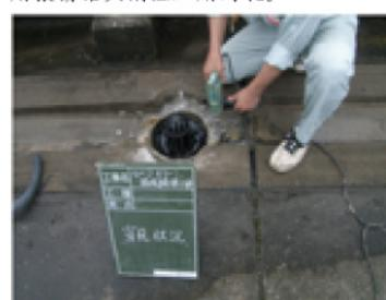
以 G1 混合高炉矿渣用化学的泵注入、回扣确认
