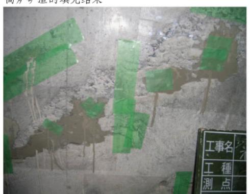
在 RC 工程中、起来向形式框框离型后的不良部分的修复工程全部性地 laitance 被覆盖、只是修复剂（灰浆）对应、贴紧性与欠缺剥落和浮、裂缝相连、白华的发生相联。
