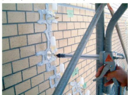
很好地清扫裂纹部分、用临时决定性的一击贴纸粘贴插头。插头间贴纸做干燥之后进行矿渣的注入。
