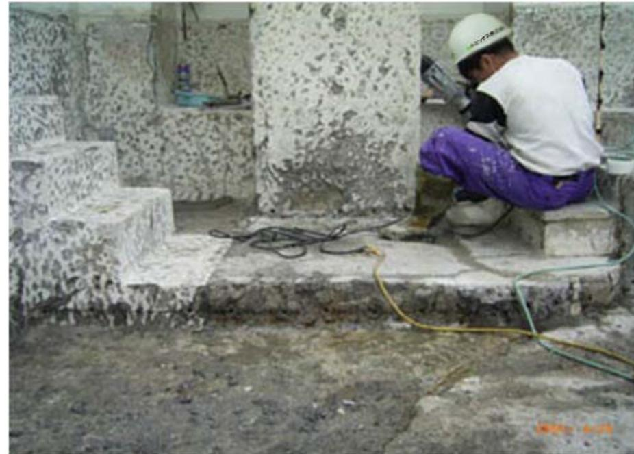
配鉄筋用のアンカー取付作業
