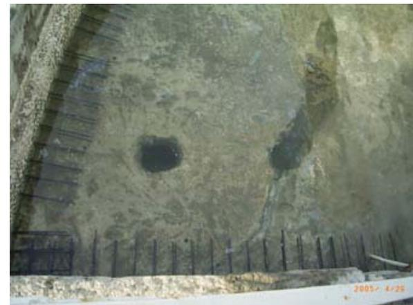
翌日、海水が退いた後、底部にコンクリートの打ち込みを行う
