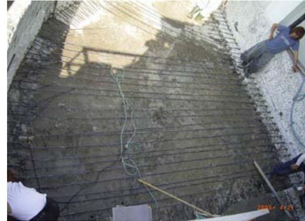
縦筋、横筋及びクロス部分を結束する
