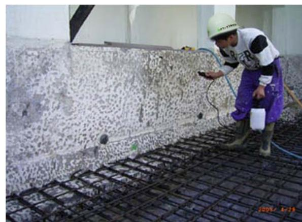
ハイドロプルーフ HT-SPを散布後、被り厚を確認しながらコンクリートの打設を行う。
