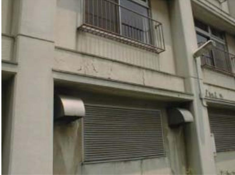
何度か表面の塗装を行ってきたようですが、大気中の二酸化炭素がコンクリート中の水酸化カルシウムと反応して pHが低下します。これにより中性化したコンクリートは表面強度を無くし、鉄筋は不動態被膜が破壊されて錆びていきます。そして、膨張、爆裂と劣化が進行していきます。
