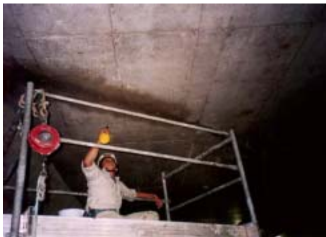
下地強化・劣化回復剤 ハイドロブルーフHT-SP塗布
