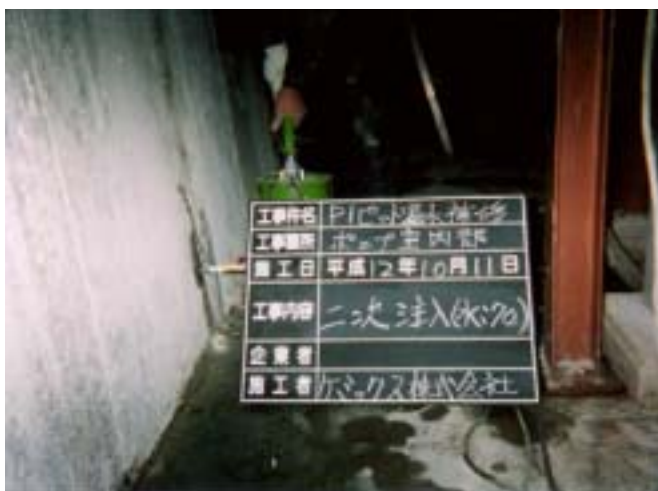
微粒子スラグ系セメント(セラミック) 2次注入
