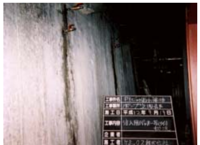
注入用パッカー取付
