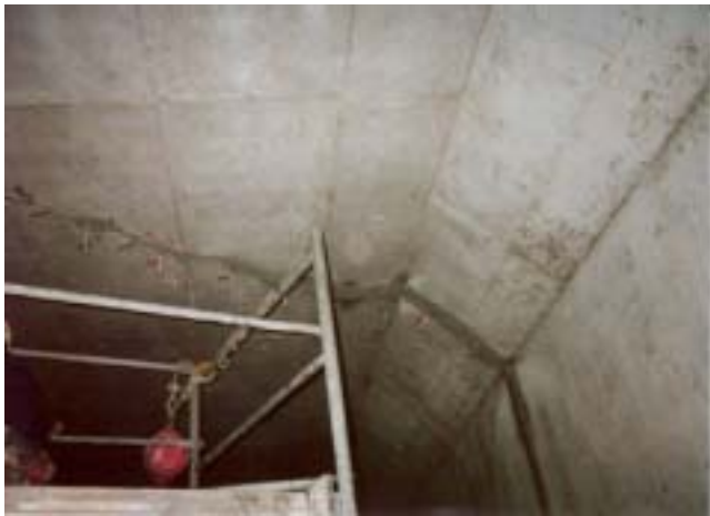
微粒子スラグ系セメント充填
