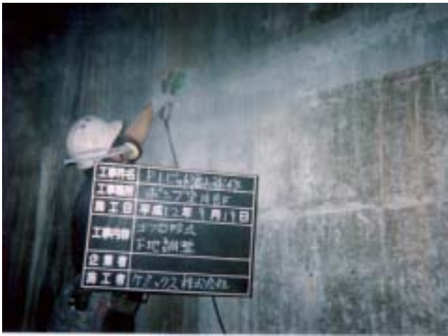
下地調整：エフロ除去
