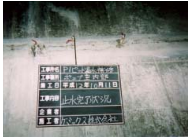
止水完了状況と注入用パッカー
