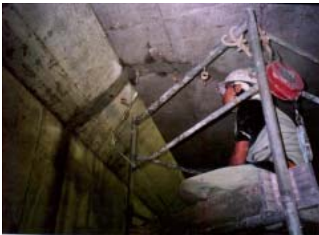
微粒子スラグ系セメント充填
