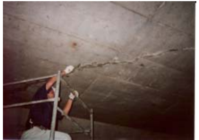
クラックVカット補修
